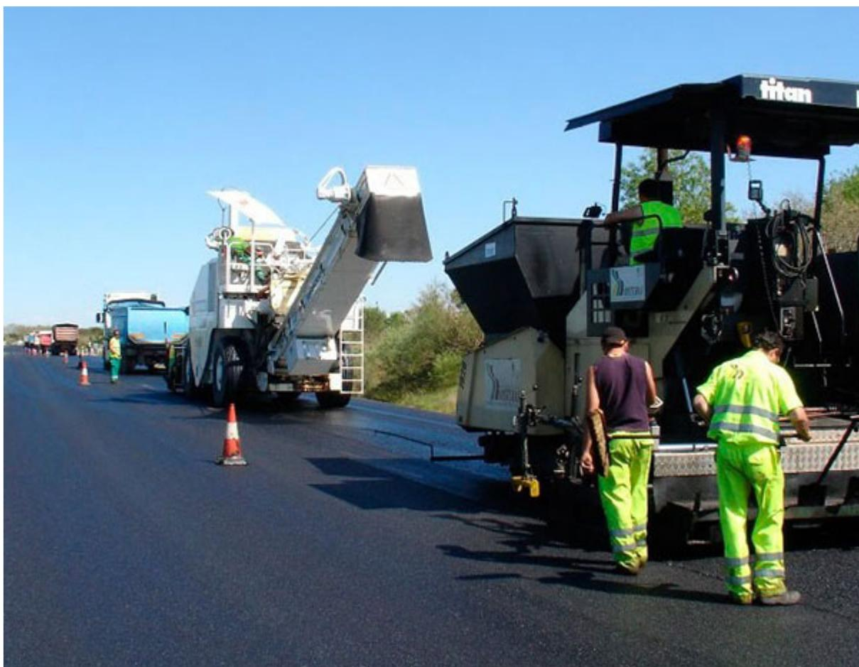
Entrando de lleno a la explicación del **pavimento asfáltico**, que es el que tiene gran uso en las carreteras federales, tenemos que se le da el término *flexible* porque puede soportar grandes cambios de temperatura sin deformarse, y más en climas extremadamente calurosos, donde las altas temperaturas hacen que los elementos estructurales se dilaten o se expandan. Un
